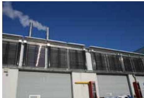
▲ A gauche : 250 m 2 de capteurs thermiques à tubes participent au process industriel. A droite : le nouveau centre logistique évite la rotation de 5.000 camions par an.
