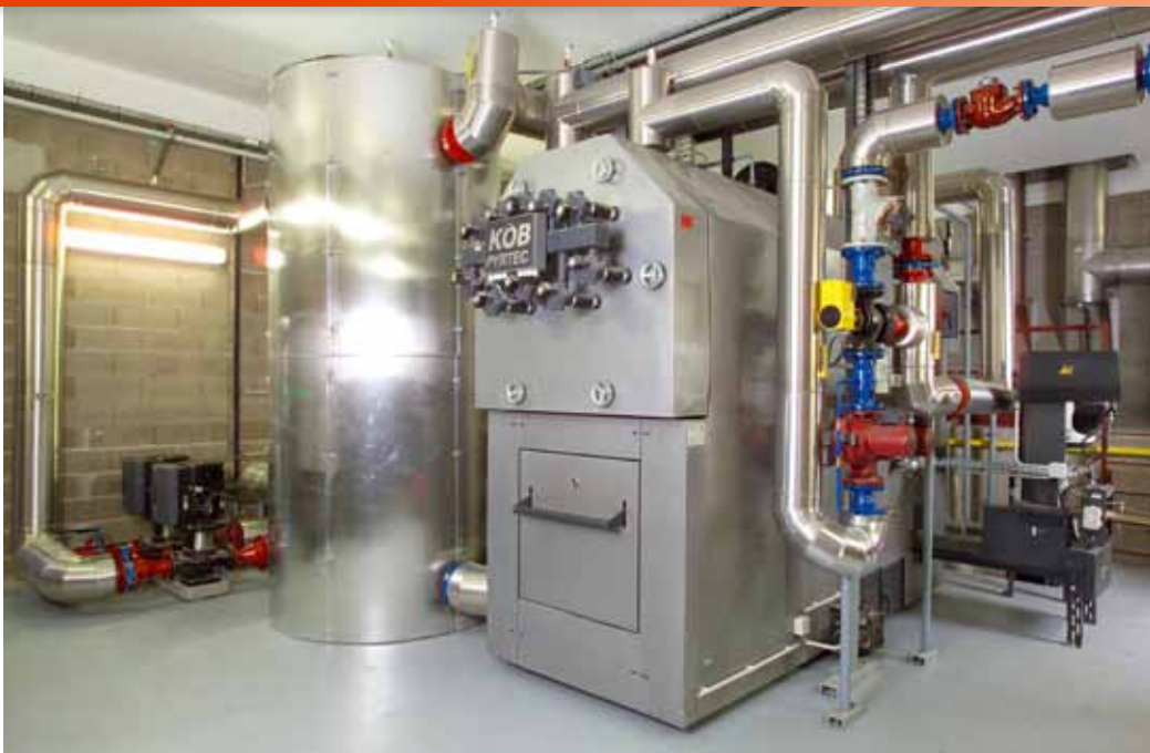
▲ La chaudière bois couvrira environ 87 % des besoins.
