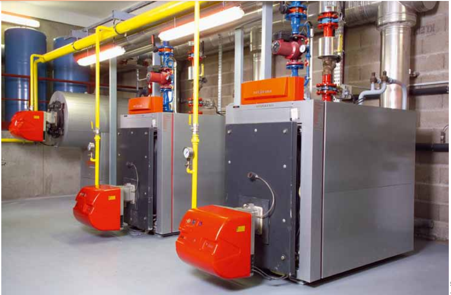
▲ Les 2 chaudières gaz basse température Vitoplan et la chaudière gaz à condensation Vitocrossal.
